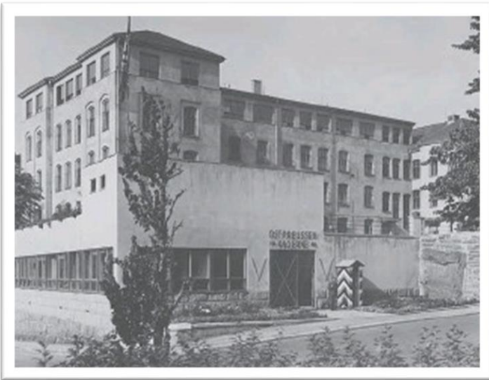
Ruseløkkabunkeren liggere under Ruseløkka skole. Nedgangen ligger utenfor skolen, fra sørsiden
